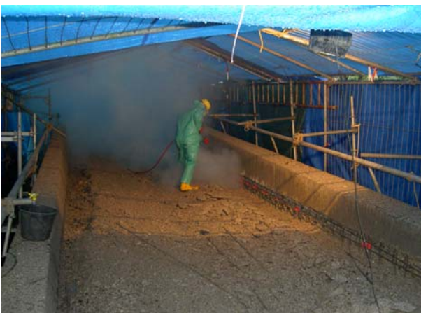
Entfernen der „chloridverseuchten“ Bereiche
