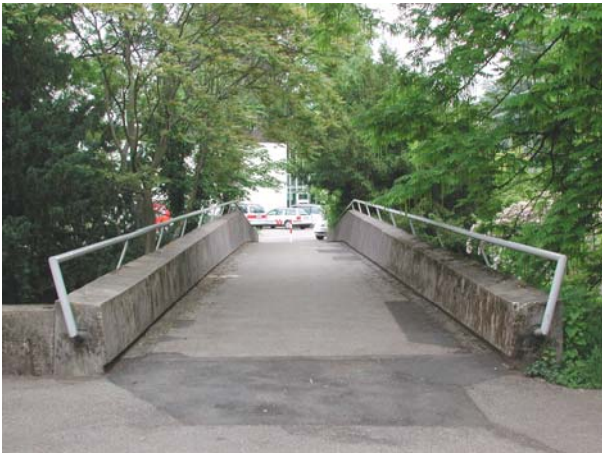
Brücke vor der Sanierung
