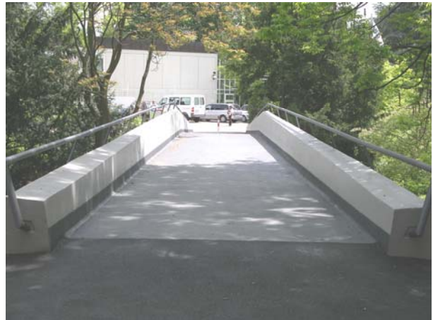
Brücke nach der Sanierung
